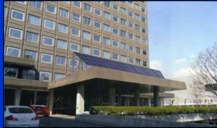
市役所本庁舎（設置イメージ） 2010年3月完成 10 kW
