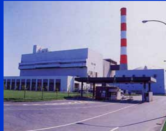
篠路清掃工場 稼動29年経過 休止予定
